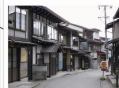
III種風町家が建ち並ぶ。緩やかなカーブはファサードを際立たせ、また坂の効果により、軒線のずれが見られる。個々の建物は多様だが、まとまりがあるように感じる。
