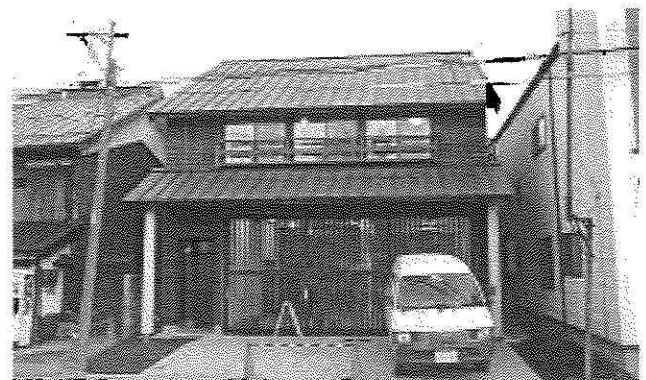
(完成したコミュニティ消防センター)
