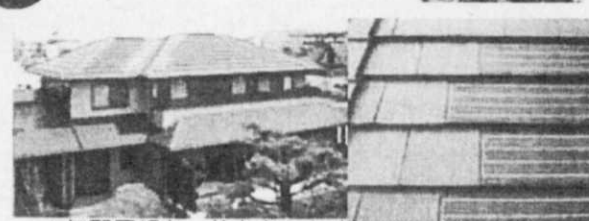
▲勾配屋根と一体となった太陽光パネル設置例
