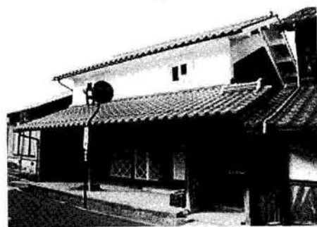
町なみ環境整備事業による住宅修景 (鳥取県鹿野町：鳥取県HPより)
