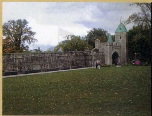
写真3 市壁の外側の公園、奥にサン・ルイ門が見える
