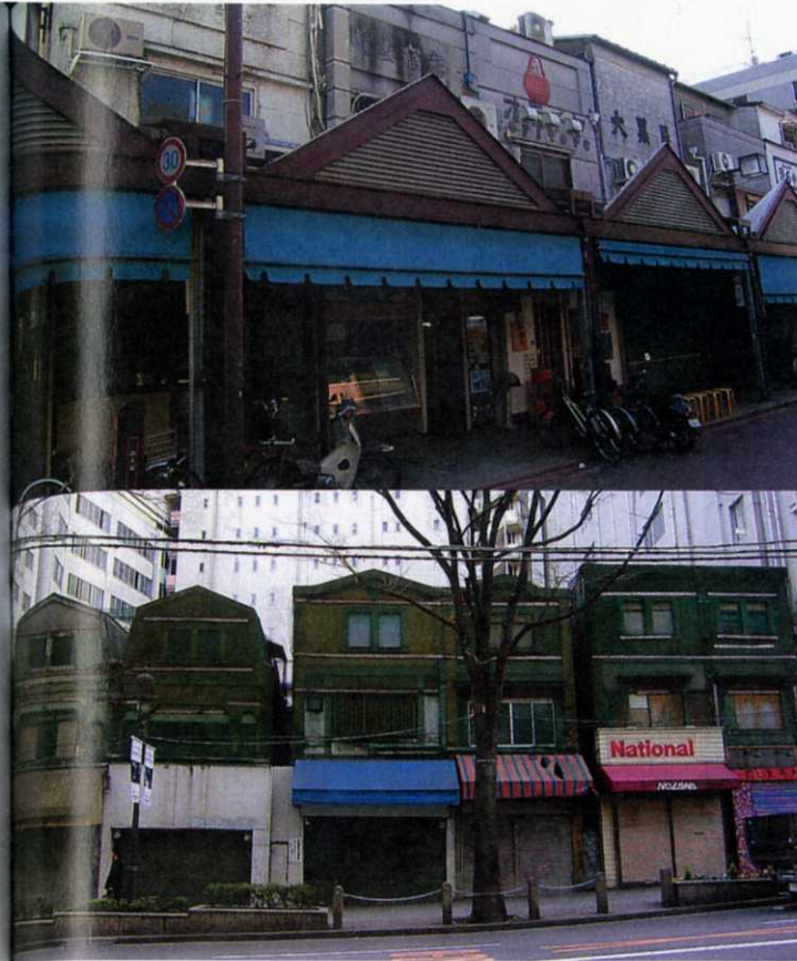
上・月島西仲通り商店街の看板建築。アーケードで見づらいのが残念。 下・渋谷の道玄坂に並ぶ看板建築。崩落防止のネットがかけられている (写真・初田香成)
