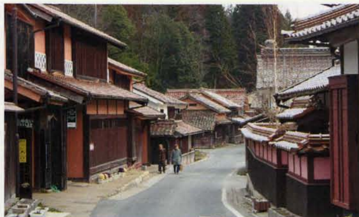
備中吹屋 江戸期ベンガラで発展し美しい景観を形成 国重要伝統的建造物群選定 県指定ふるさと村
