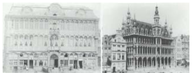
写真-1 (左)王の館再建前、(右)再建後(出典:6)
