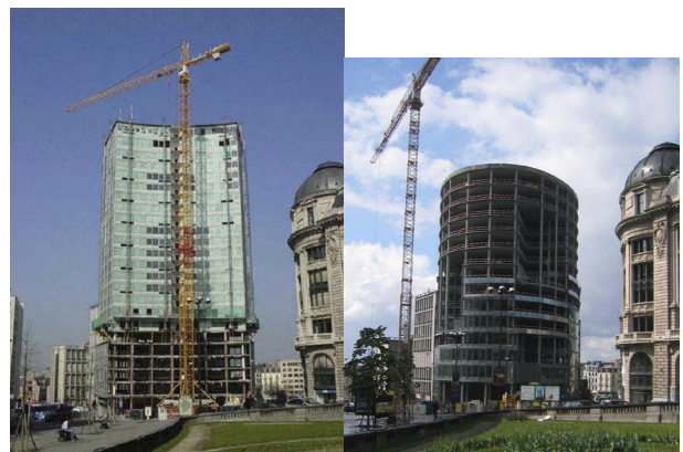
写真-1：取り壊し・建替え中のロト・タワー
