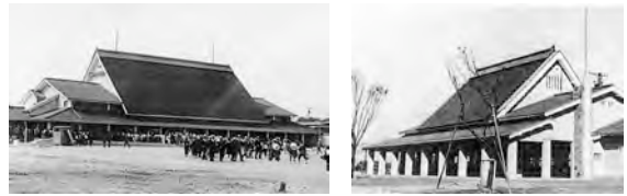
図2 大和棟を基調とした橿原神宮駅(左)と畝傍御陵前駅(右) (『橿原神宮と建国奉仕隊』所収)
